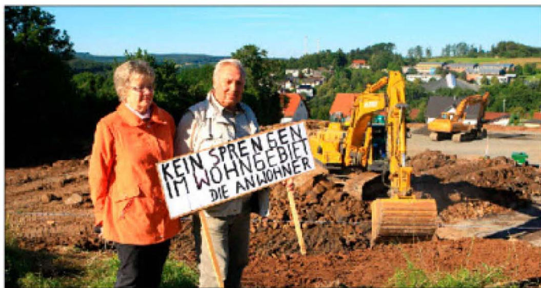
Inge und Lukas Schute fordern am Rande der Netto-Markt-Baustelle in Driedorf den Verzicht auf Sprengarbeiten im Wohngebiet. (Foto: Gerdaul)
